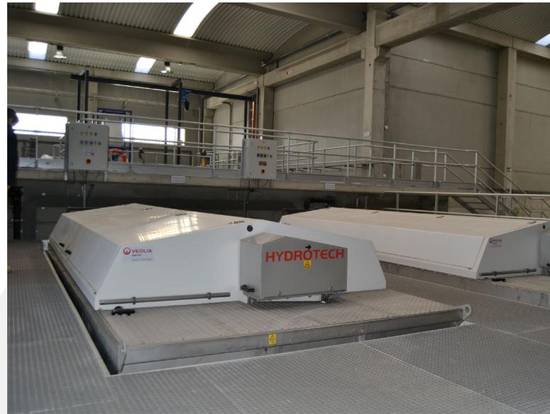
Los discos están sumergidos en este tanque en un 60-65%, para permitir que los filtros puedan seguir funcionando durante el lavado de las telas. El lavado de estos microtamices se realiza con agua a contracorriente y con limpiezas químicas.
