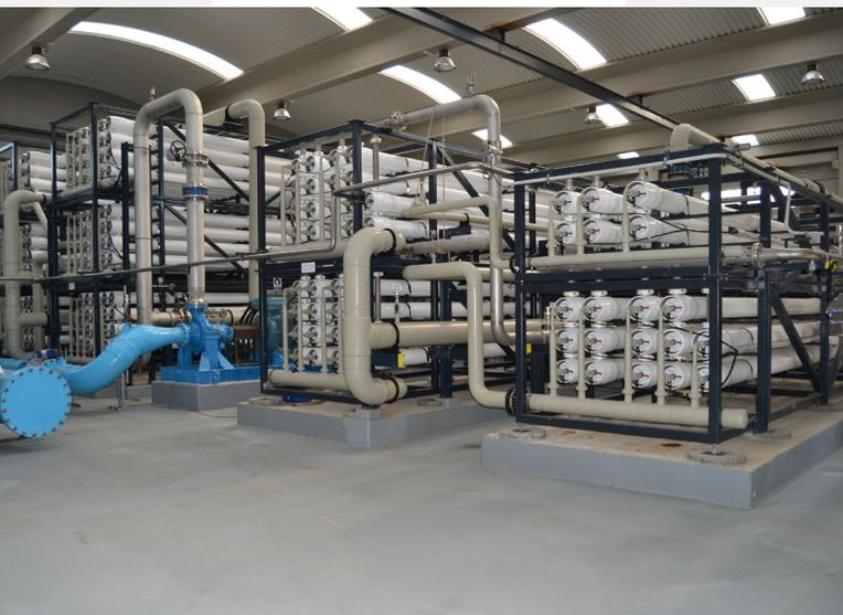
A continuación, el agua llega a la planta de ósmosis inversa que está configurada en base a 2 líneas de doble paso y 3 etapas cada paso, con un factor de conversión del 75% el
