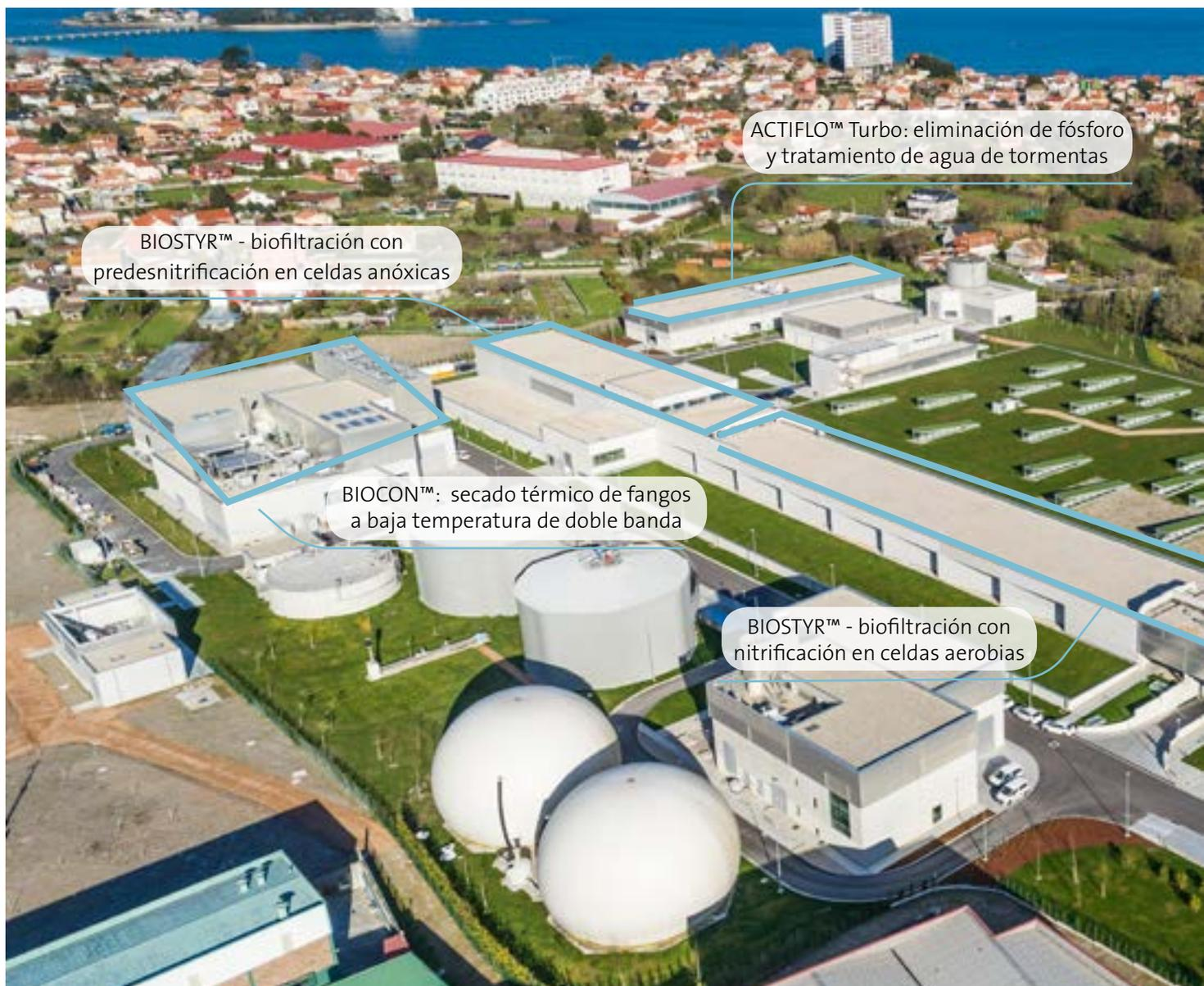
BIOSTYR™ - biofiltración con predesnitrificación en celdas anóxicas
