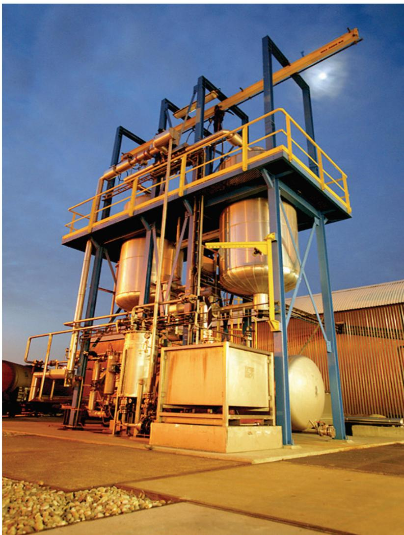
Foto 3. Tipo de construcción MPPE ensamblado in situ; Caudales de 3 a 165 m<sup>3</sup>/h. Estos son compactos, económicos y requieren montaje en el sitio
