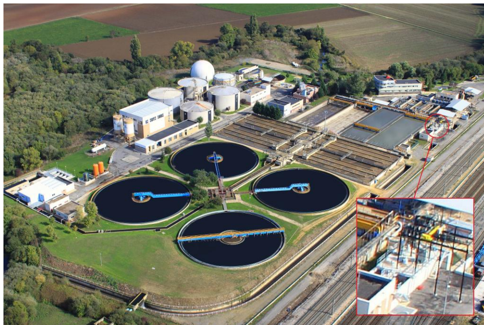
Figura 3. Fotografía aérea del sistema Actiflo® Turbo para tormentas en la EDAR de Crispijana
